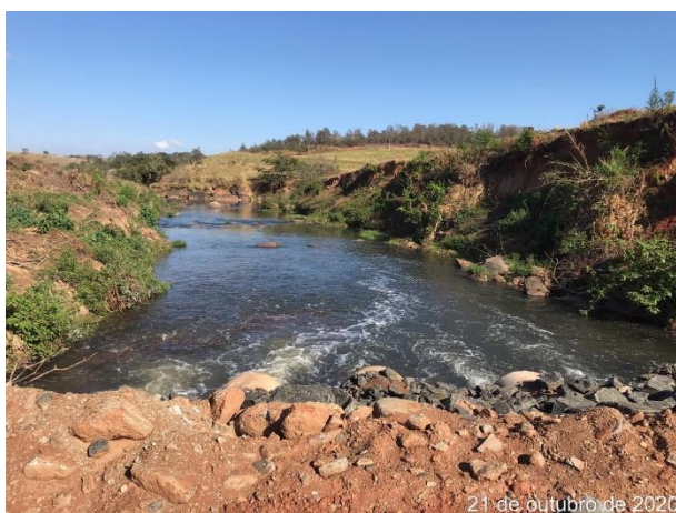
Foto 111 – Passagem Molhada rio Camanducaia (Data: 21/10/20)
