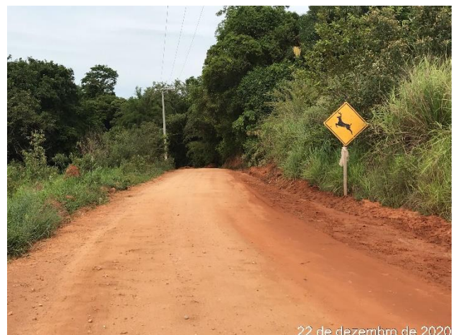
Foto 84 – Rua municipal acesso a Obra. (Data:22/12/2020)
