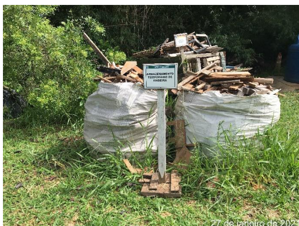
Foto 161 – Armazenamento temporário de resíduo de madeira no canteiro operacional. (Data:27/01/2021)
