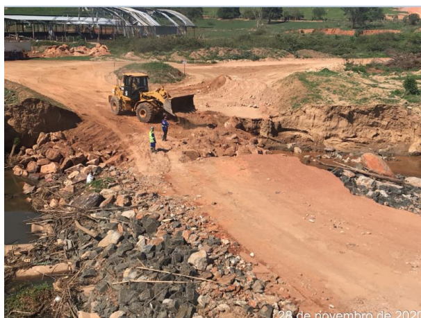
Foto 119 – Finalização da manutenção da passagem molhada no rio Camanducaia. (Data: 28/11/2020)
