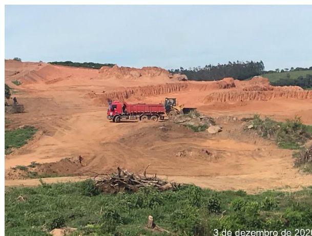
Foto 128 – Remoção de material solto. (Data:03/12/2020)
