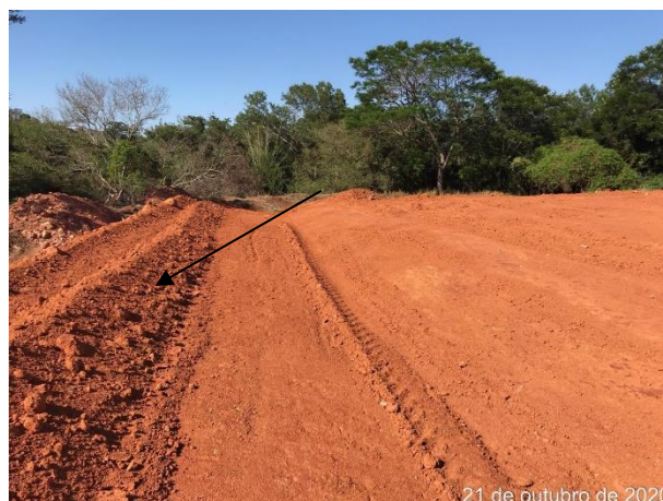
Foto 104 – Leiras para contenção de sedimentos Bota Espera Margem direita. (Data: 21/10/20)
