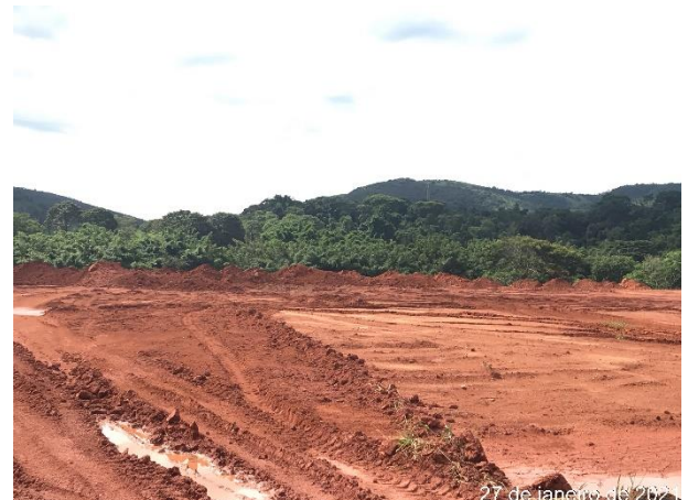
Foto 166 – Movimentação de terra na M.D bota espera. (Data:27/01/2021)
