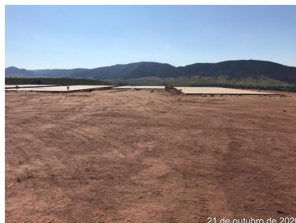
Foto 108 – Canteiro Industrial. (Data: 21/10/20)
