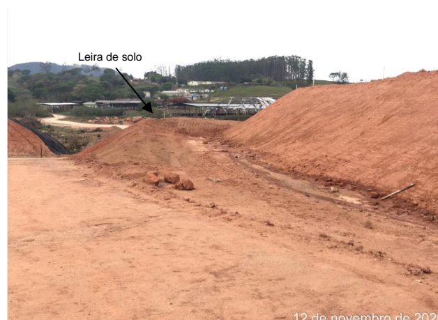
Foto 116 – Monitoramento do Bota Fora Margem Esquerda. (Data: 12/11/2020)
