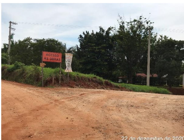
Foto 83 – Via externa da Obra (Data: 22/12/2020)
