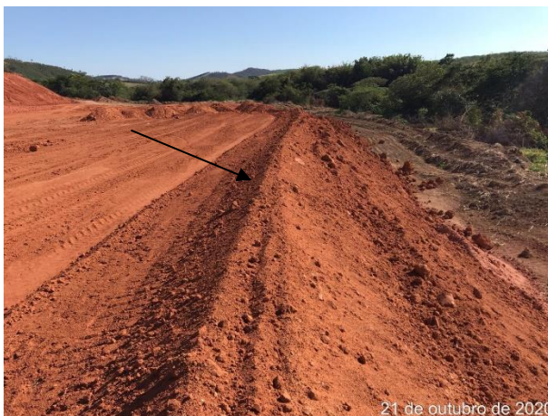
Foto 93 – Leiras para contenção de sedimentos Bota Espera Margem direita. (Data: 21/10/20)
