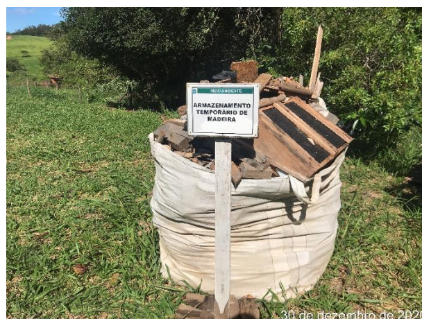
Foto 155 – Armazenamento temporário de resíduo de madeira no canteiro operacional. (Data: 30/12/2020)
