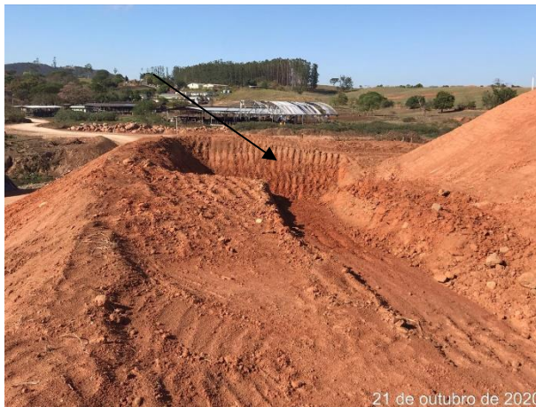
Foto 97 – Cacimba para contenção de sedimentos Bota Espera Margem direita. (Data: 21/10/20)
