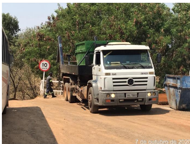
Foto 147 – Retirada de resíduo comum do canteiro por empresa contratada. (Data: 07/10/20)
