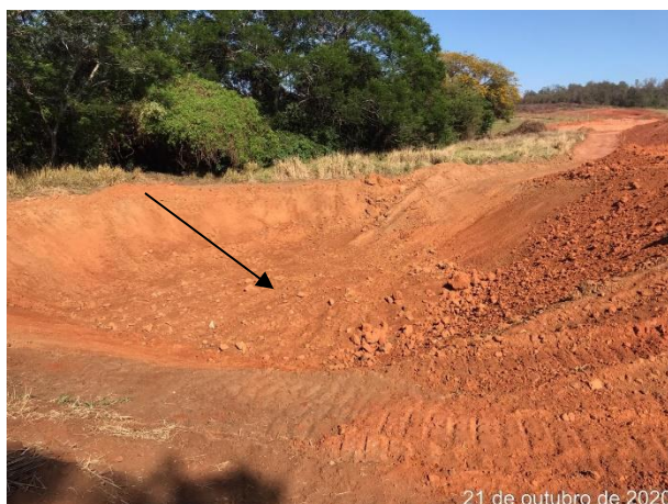
Foto 103 – Cacimba para contenção de sedimentos Bota Espera Margem direita. (Data: 21/10/20)
