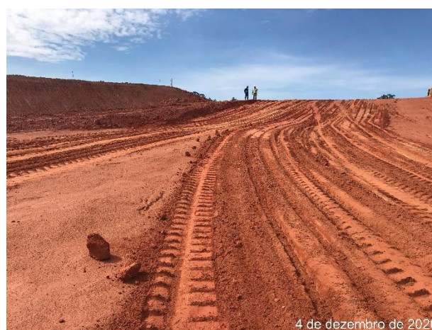
Foto 126 – Regularização de erosão e direcionamento da água. (Data:04/12/2020)
