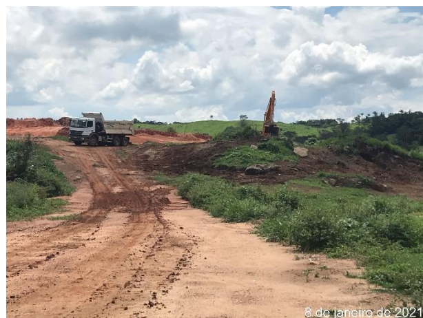
Foto 135 – Remoção de solo solto evitando carreamento. (Data:08/01/2021)
