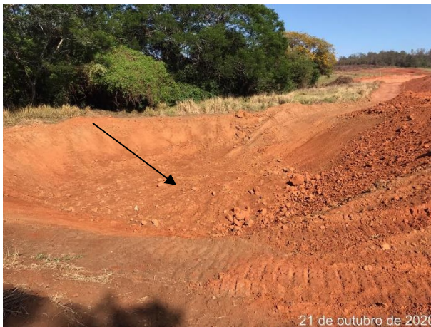
Foto 91 – Cacimba para contenção de sedimentos Bota Espera Margem direita. (Data: 21/10/20)
