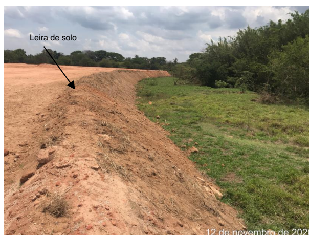
Foto 115 – Monitoramento do Bota Fora Margem Esquerda. (Data: 12/11/2020)
