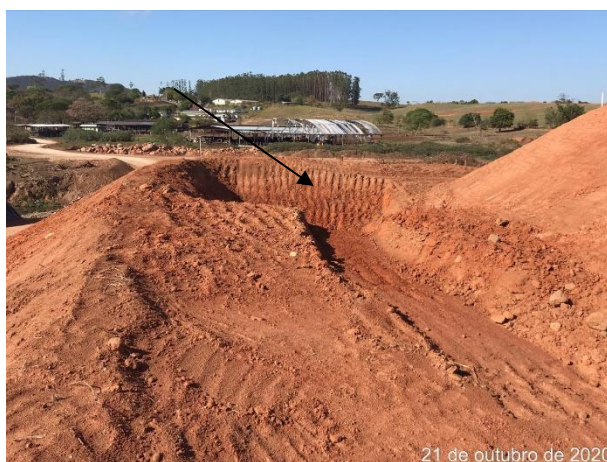
Foto 109 – Cacimba para contenção de sedimentos Bota Espera Margem direita. (Data: 21/10/20)
