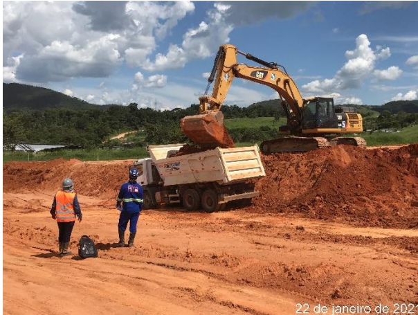
Foto 163 – Movimentação de terra na galeria, margem esquerda. (Data:22/01/2021)
