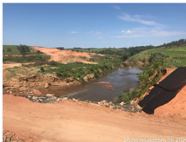
Foto 120 – Finalização da manutenção da passagem molhada no rio Camanducaia. (Data: 28/11/2020)
