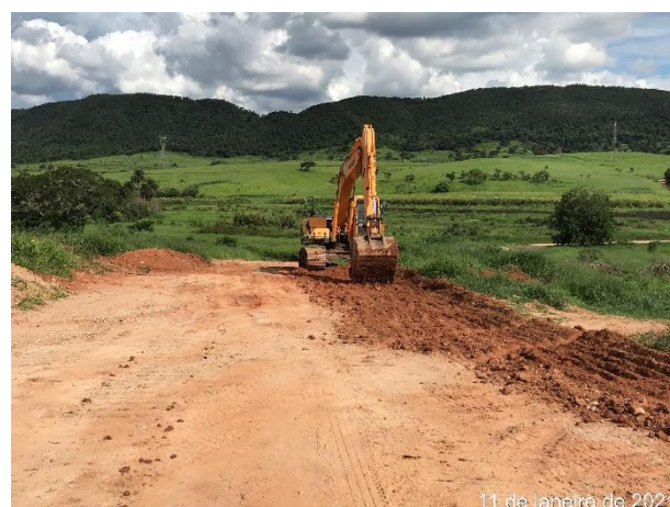
Foto 130 – Direcionamento da água próximo ao pantaleão. (Data:11/01/2021)
