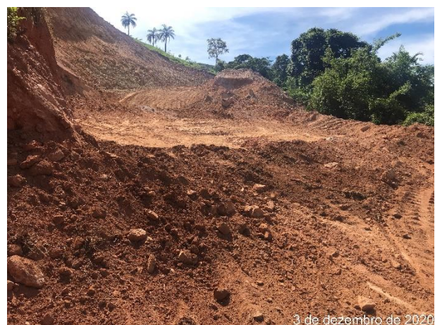
Foto 127 – Leiras para amortecimento da águas da chuva, Cascalheira. (Data: 03/12/2020)
