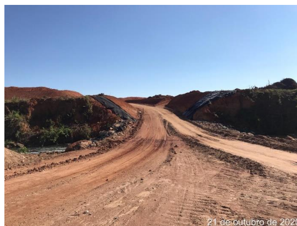
Foto 112 – Passagem Molhada rio Camanducaia (Data: 21/10/20)
