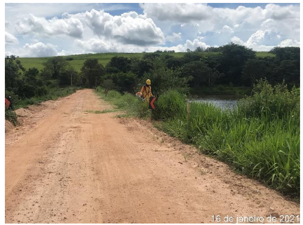
Foto 50 – Roçada do mato no acesso ao canteiro administrativo. (Data:16/01/2021)
