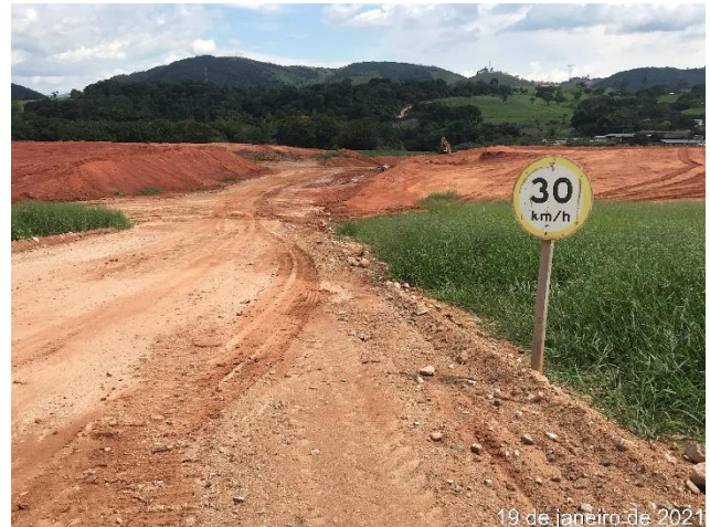
Foto 90 – Via interna da obra. (Data: 19/01/2021)
