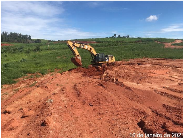
Foto 131 – Disciplinamento das águas pluviais no bota espera M.D. (Data: 16/01/2021)
