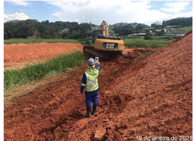
Foto 142 – Escavadeira Hidráulica. (Data:19/01/2021)
