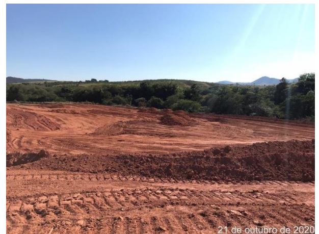
Foto 94 – Área do Bota Espera com disciplinamento de água e leira para proteção. (Data: 21/10/20)
