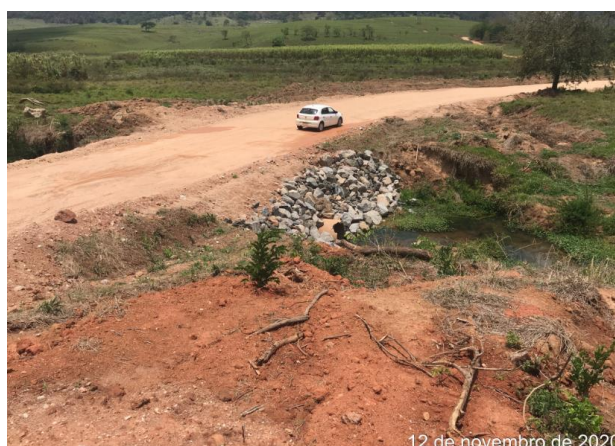
Foto 117 – Monitoramento da Passagem Molhada do córrego Pantaleão. (Data: 12/11/2020)
