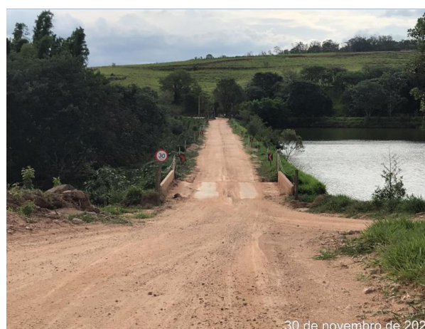
Foto 88 – Sinalização interna da obra. (Data: 30/11/2020)
