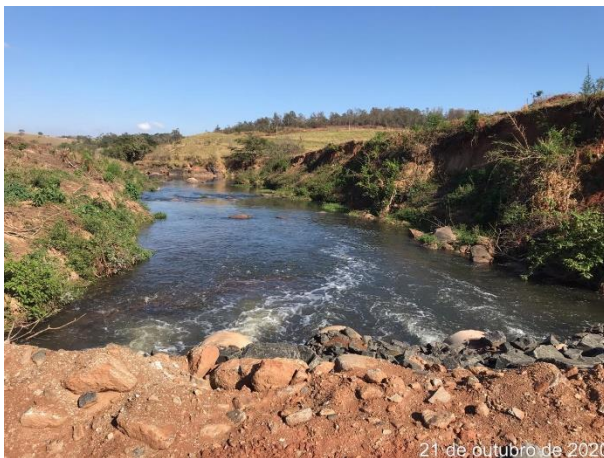
Foto 99 – Passagem Molhada rio Camanducaia (Data: 21/10/20)
