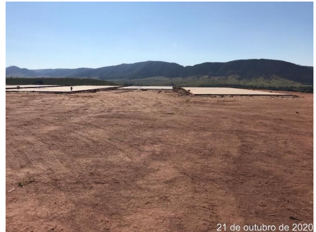
Foto 96 – Canteiro Industrial. (Data: 21/10/20)
