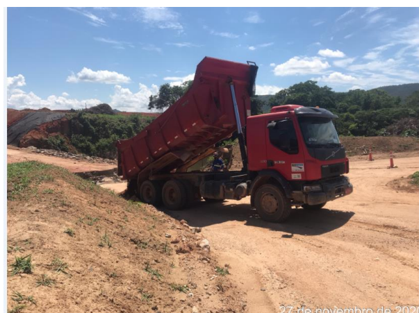
Foto 118 – Manutenção da passagem molhada no rio Camanducaia. (Data: 27/11/2020)
