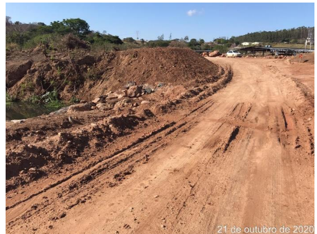
Foto 98 – Passagem Molhada Rio Camanducaia (Data: 21/10/20)
