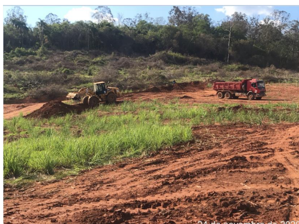
Foto 123 – Limpeza e condicionamento do fluxo de água pluvial. (Data: 24/11/2020)
