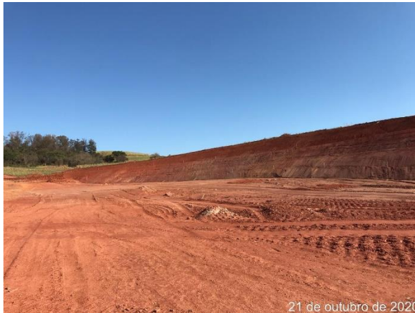
Foto 95 – Bota espera Margem Direita. (Data: 21/10/20)
