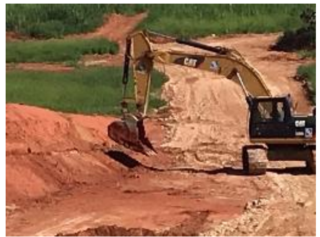
Foto 134 – Compactação de taludes M.D bota espera. (Data:16/01/2021)
