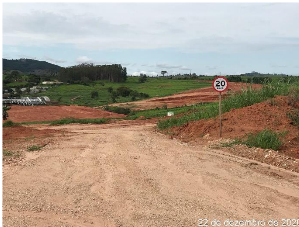
Foto 89 – Via interna da obra. (Data: 22/12/2020)
