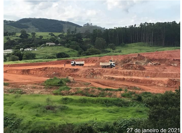
Foto 164 – Movimentação de terra na margem esquerda. (Data:27/01/2021)
