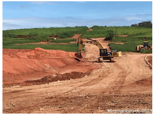
Foto 132 – Reafeiçoamento e compactação dos taludes. (Data:16/01/2021)
