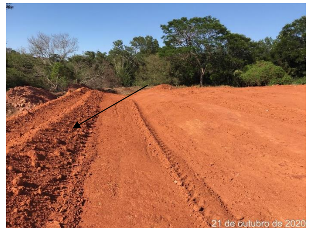
Foto 92 – Leiras para contenção de sedimentos Bota Espera Margem direita. (Data: 21/10/20)
