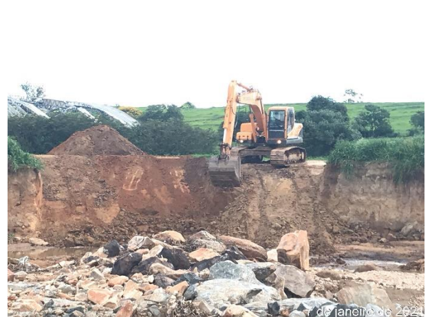
Foto 136 – Reconstrução da passagem molhada do rio Camanducaia após forte precipitação pluviométrica. (Data:07/01/2021)
