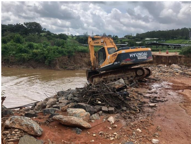
Foto 133 – Desobstrução da tubulação da passagem molhada. (Data:16/01/2021)
