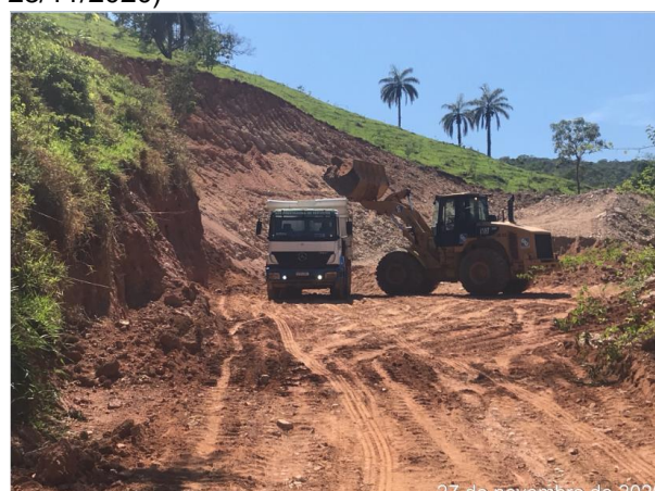
Foto 124 – Limpeza e condicionamento do fluxo de água pluvial da jazida. (Data: 27/11/2020)
