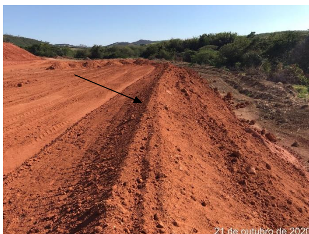
Foto 105 – Leiras para contenção de sedimentos Bota Espera Margem direita. (Data: 21/10/20)
