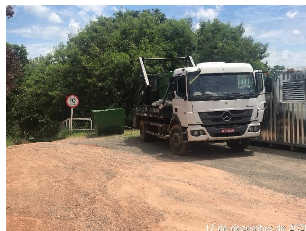
Foto 156 – Troca de caçamba de resíduo comum no canteiro administrativo. (Data: 17/12/2020)
